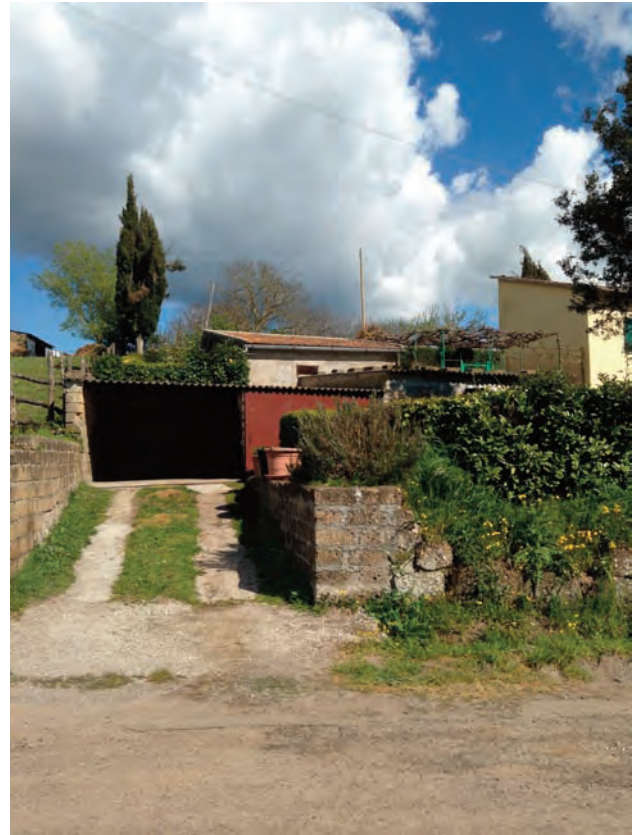
unità edilizia: E 057E1
