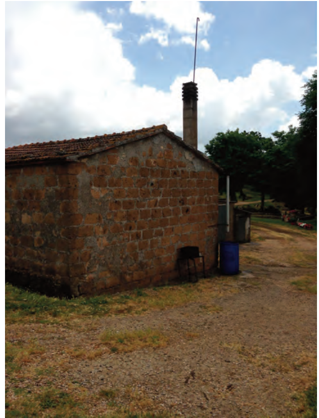
unità edilizia: E 091E2
