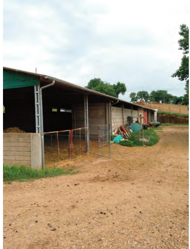
unità edilizia: E 121E2
