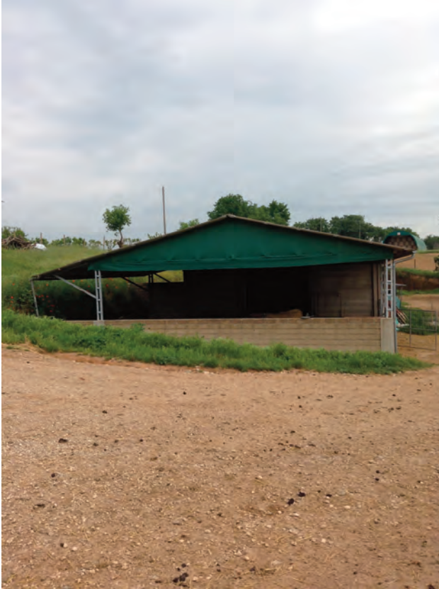
unità edilizia: E 121E1
