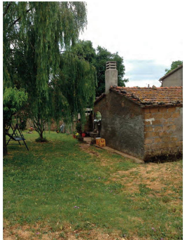
unità edilizia: E 091E4
