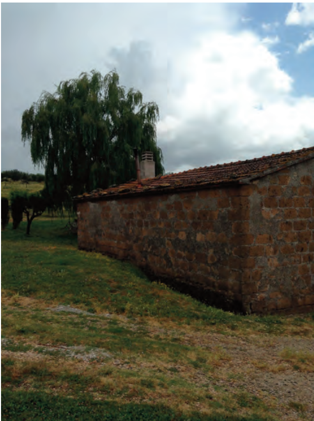
unità edilizia: E 091E3
